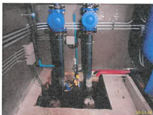
ปั๊มระบบระบายน้ำฝนชั้นใต้ดิน
