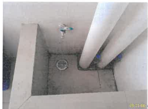
ก๊อกน้ำ และรูระบายน้ำ ห้องพักขยะประจำชั้น แบบที่ 2
