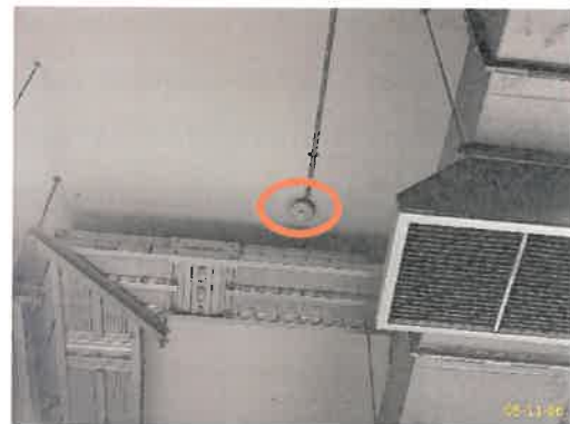
เครื่องตรวจจับควัน และระบายอากาศ
